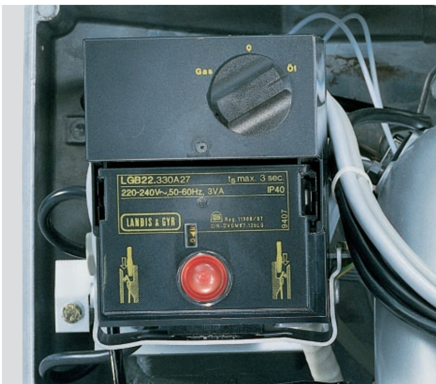
Смена режима работы газ/жидкое топливо осуществляется просто переключателем на автомате горения
