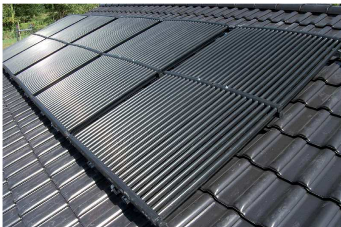
Воздушно-солнечный абсорбер для тепловых насосов с аккумулятором холода
