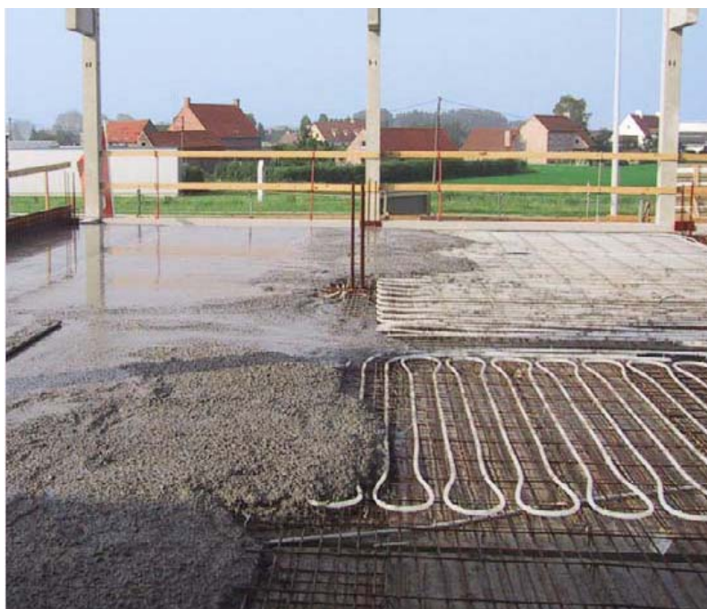
Рис. 11: Охлаждение строительных конструкций – изготовление бетонных перекрытий с использованием трубной разводки
