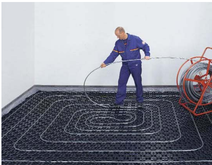
Рис. 10: Прокладывание системы напольного отопления/охлаждения
